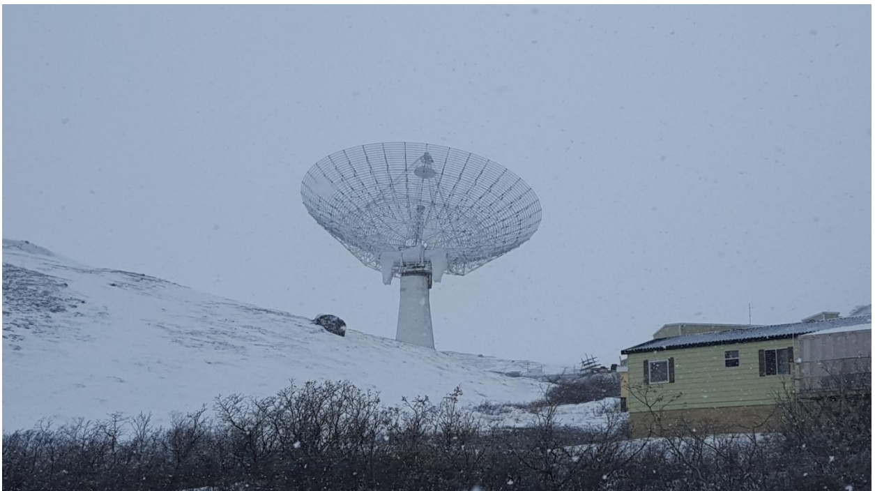
Abb. 2 ~ 32 Meter Parabolspiegel mit Radarstation rechts. Horrend starke Radio-Signale mit 500 Mega Watt bei 1260 MHz werden in die Ionosphäre gestrahlt und die Radio-Echos gemessen und studiert. Nachts leuchtet ein grüner Laser weit in den Himmel für spezielle Forschungsprogramme. Der grosse Radar-Spiegel, der grüne Laser und die sich bewegende Aurora hinterlassen einen tiefen, unvergesslichen Eindruck.
